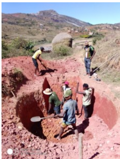
Réalisation de la fouille devant recevoir le bio-digester
